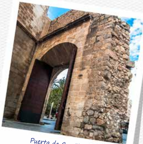
Puerta de Crevillente. Restos de muralla.
