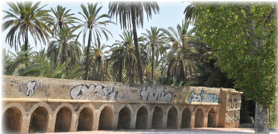
El acueducto de la Acequia de la Escorrata es un buen ejemplo de ingeniería hidráulica asociada a los cultivos de huerta que se presentan en todo el entorno del Palmeral de Orihuela.
